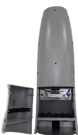
Figure 6-3 - Vista esterna involucro aperto
